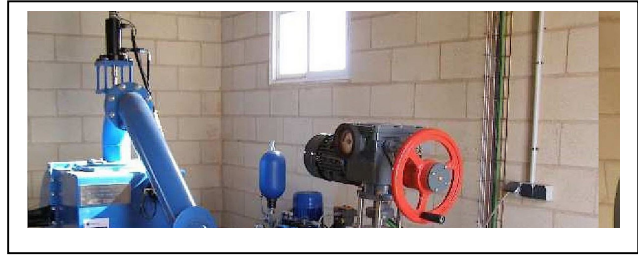
Fig. 2. Conjunto turbina-generator.
