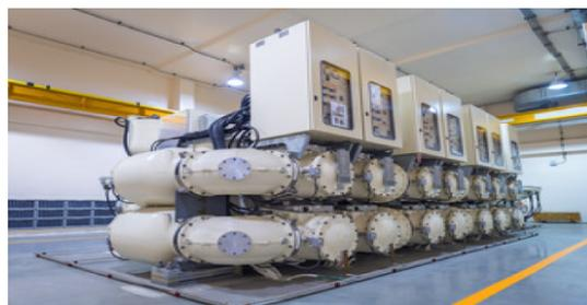
FIGURA 10. Subestación típica encapsulada en SF6 [17].
