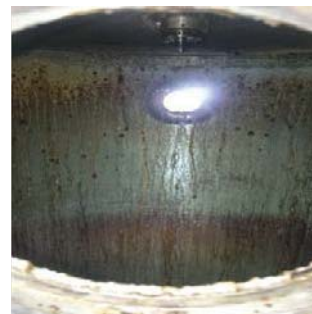
Figura 5. Deposición de material en la pared de la cámara utilizando atomizador de disco rotatorio.
